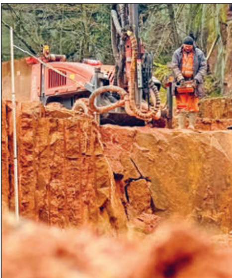
Die Abbrucharbeiten werden von einer externen Firma durchgeführt.
