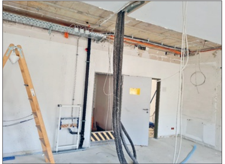
Bei der Erweiterung der Regenbogen-Grundschule entstehen neue Klassenzimmer. Die Rohbauarbeiten sind weitgehend abgeschlossen.
