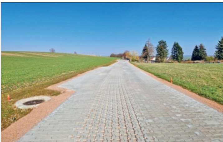
Für die Straßenbeleuchtung des fertiggestellten Pestwegs wurden Fördermittel beantragt. Eine Ausführung ist frühestens ab Mai 2025 geplant.
