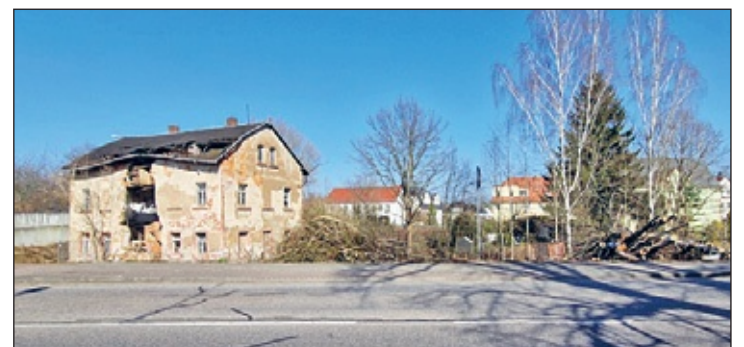
Der Abbruch des Hauses in der Leipziger Straße 48 ist von Ende Mai bis Mitte Juni 2025 geplant.
