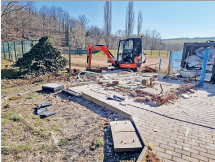
Das Kassenhäuschen des Freibades wurde bereits abgerissen, um das Baufeld freizumachen.
