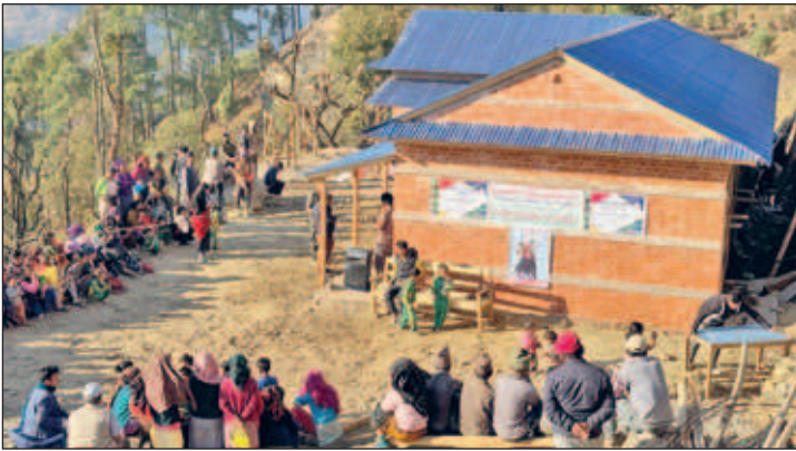
Dank des 14. Benefizkonzertes in 2023 konnte ein Kindergarten in Nepal gebaut werden.
