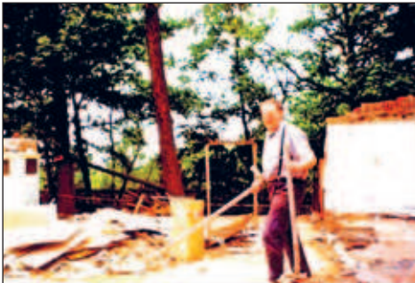
Eberhard Enghardt beim Abriss des massiven Küchentraktes im Jahre 2001
