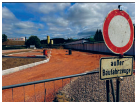
Über den Zaun geschaut (Anfang Mai): Hier entstehen 62 Parkplätze.
