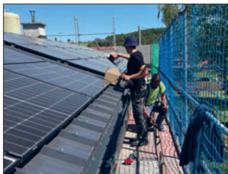
Mitarbeiter der Firma EGH Hartha montieren die Photovoltaik-Module.
