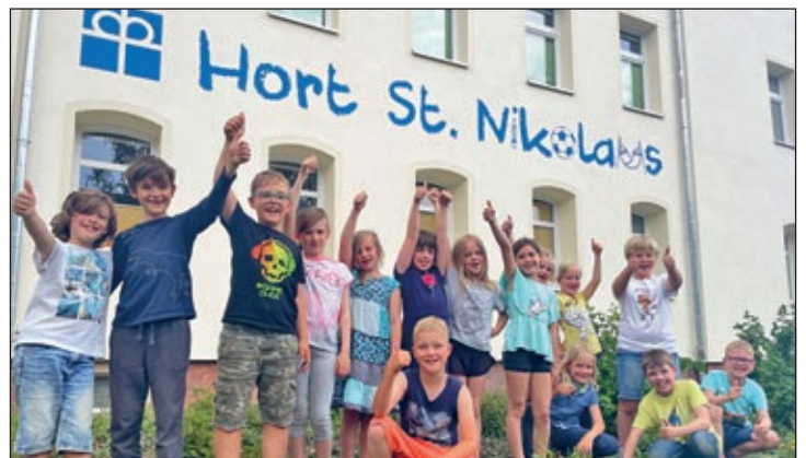
Neuer Fassadenanstrich des Hortgebäudes der Diakonie.
