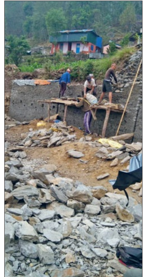
Bau der Schutzmauer
