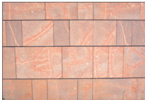
Gesägte Platten aus Rochlitzer Porphyrtuff an der modernen Fassade des Stadtgeschichtlichen Museums in Leipzig.
