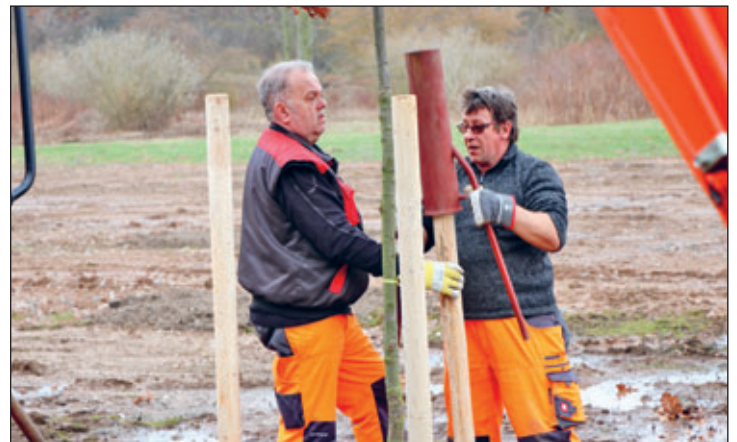
Die Bauhofmitarbeiter Bodo Lippmann und Werner Hertlitschke beim Verankern der Stützpfosten.
