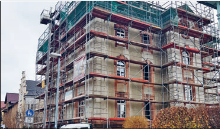
Investition im Wohnungsbau - Leipziger Unternehmen GOLZ Wohnbau GmbH saniert und modernisiert ehemaliges Verwaltungsgebäude in der Bismarckstraße.
