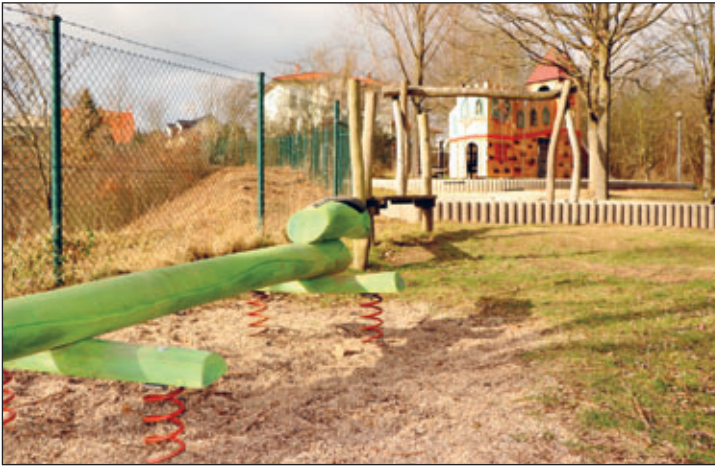
Spielplatz Am Eichberg wurde grundhaft saniert.
