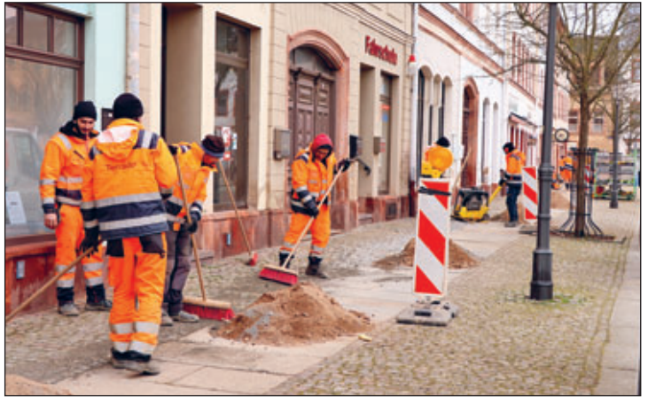
Für leistungsstarkes Internet wurden im Stadtgebiet neue Glasfaserkabel verlegt.
