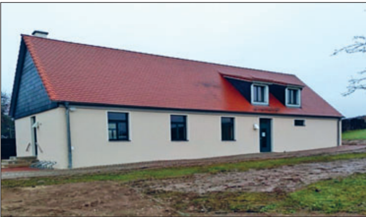
Neuer Außenputz für Dorfgemeinschaftshaus Penna
