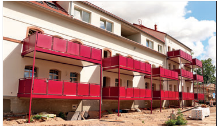
Baufertigstellung Wohngebäude „Alte Brauerei“ – Die ersten Mieter bezogen im August ihre neue Wohnung. Das Leipziger Unternehmen Golz Wohnbau GmbH hatte das alte Brauereigebäude erworben, vollständig saniert und 12 Wohnungen mit hohem Wohnkomfort geschaffen.
