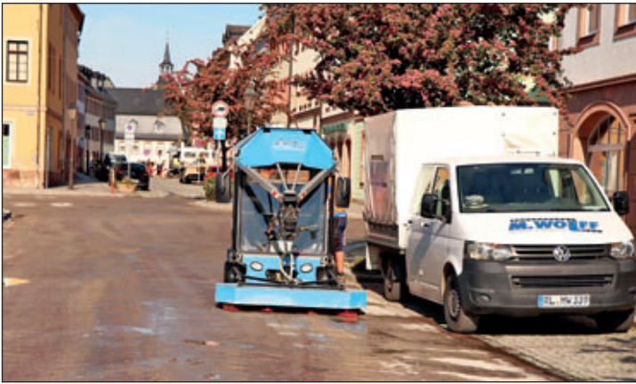
Durch die Einsandung der Pflasterfugen soll der Straßenbelag widerstandsfähig und lange haltbar gemacht werden. Das städtische Bauamt hatte die Maßnahme im Bereich Markt Abschnitt Muldengasse bis zur Kreuzung Rathausstraße/ Bahnhofstraße angeordnet.
