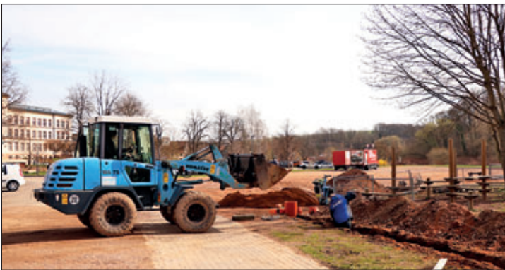
Festplatz Bleiche trockengelegt. Zur Entwässerung des Festplatzes und der damit verbundenen besseren Begehrbarkeit, insbesondere bei Schausteller- und Zirkusgastspielen, wurde dort ein Drainagesystem installiert.
