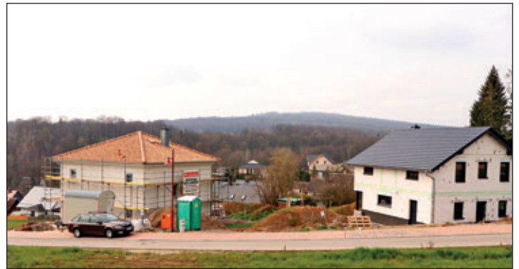
Nach Fertigstellung der Erschließungsarbeiten im Wohngebiet „Am Weinberg“ standen 21 Baugrundstücke zum Verkauf. Bereits im Frühjahr 2021 waren aufgrund der großen Nachfrage keine Parzellen mehr verfügbar.
