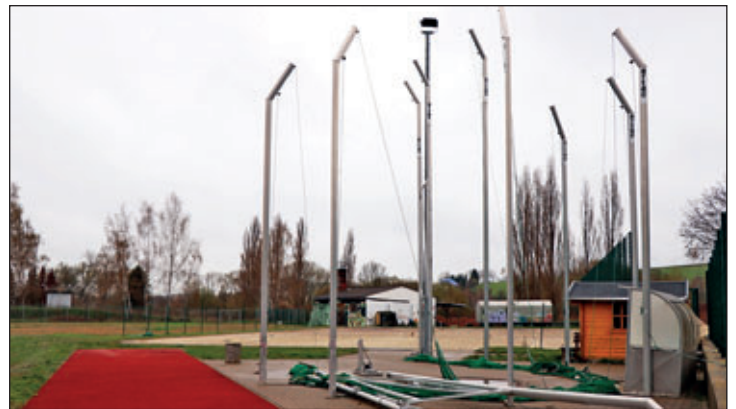
Die defekte Speer- und Diskuswurfanlage im Vater-Jahn-Stadion wurde mit einem finanziellen Aufwand von rund 17.000 Euro instandgesetzt.
