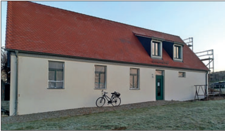
Am Dorfgemeinschaftshaus Penna erfolgte die Sanierung der äußeren Hülle Bildrechte: Christa Gentsch
