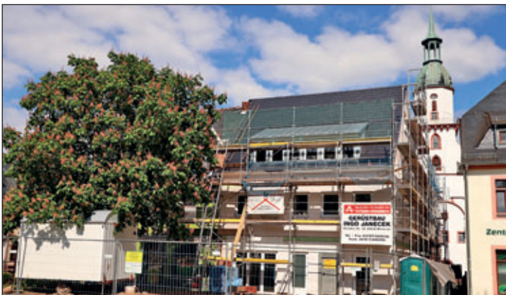
Investor schließt Baulücke Topfmarkt / Kirchgasse 1 und 3. Für die Investition in Höhe von über 1,1 Mio Euro stellten Stadt, Land und Bund rund 34 % an Fördermitteln zur Verfügung.
