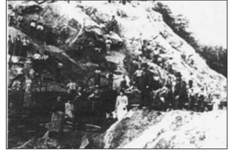
Straßenbau in Döhlen
