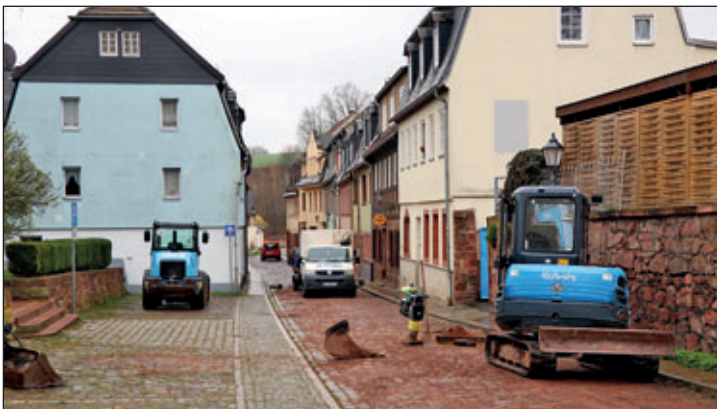
Über die gesamte Länge der Dresdner Straße erfolgte eine Teilsanierung des partiell desolaten Natursteinpflastes.
