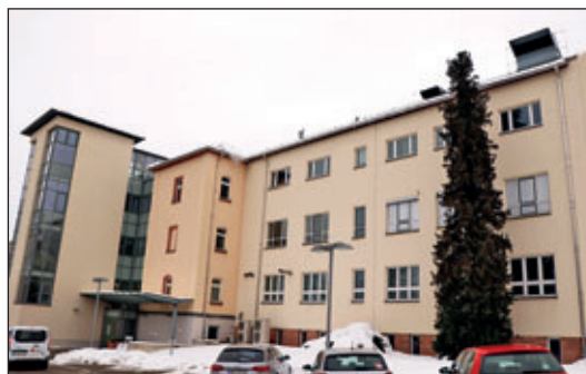
Ehemaliges Krankenhaus Rochlitz wird zum Gesundheits- und Pflegezentrum „Lindenblick“ ausgebaut. 2022 soll offizielle Eröffnung sein.
