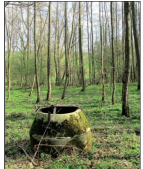
Einer der Revisionsschächte der Noßwitzer Leitung im Hellerbachtal /Foto: W&R Richter, Noßwitz 2020/
