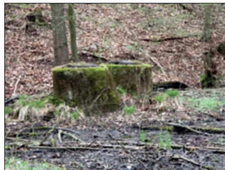
Das ehemalige Wassereinzugsgebiet mit Sammelschächten der Noßwitzer Leitung in der Noßwitzer Senke /Foto: W&R Richter, Noßwitz 2020/
