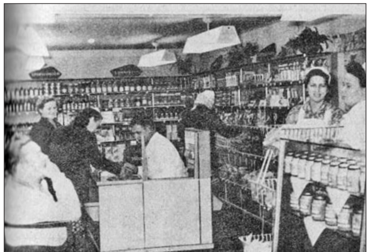
Zur Erhöhung der Leistungen und der Verkaufskultur baute die Konsumgenossenschaft Rochlitz in Schwarzbach diese allen Ansprüchen gewachsene Selbstbedienungsverkaufsstelle. Durch diesen Umbau ist es möglich, ein weit größeres Warenangebot als bisher zur Verfügung zu stellen und zu beweisen, daß die Landbevölkerung der Stadtbevölkerung in keiner Weise nachstehen soll.
