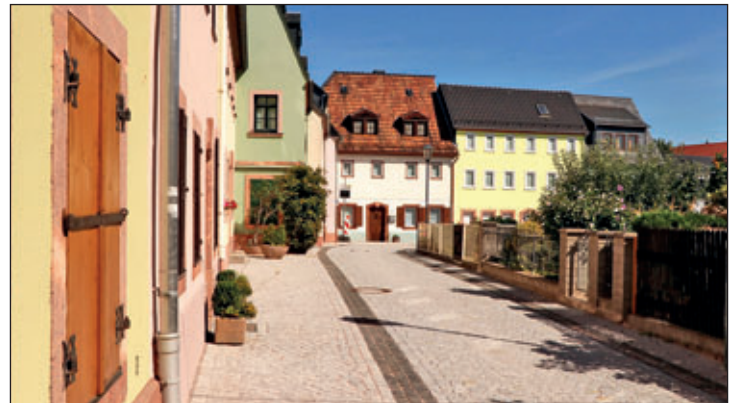
Zwinger- und Wallgasse sind nach drei Monaten Bauzeit fertiggestellt. Die Gesamtkosten belaufen sich auf rund 135.000 Euro.
