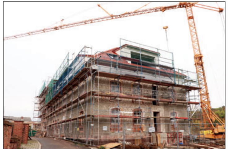
Auf dem 6.000 qm großen Areal entstehen 14 Eigentumswohnungen.
