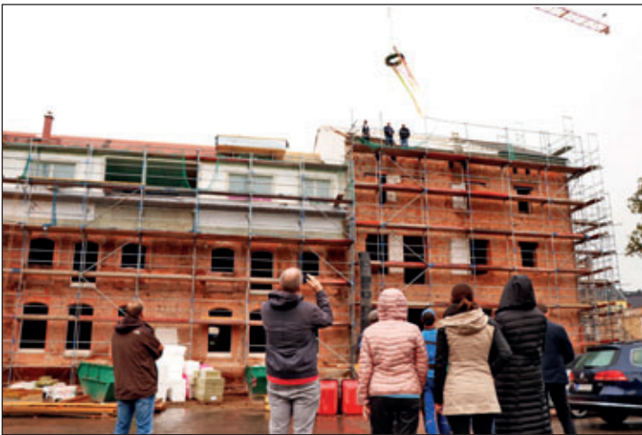
Richtfest am Wohngebäude "Alte Brauerei" am Topfmarkt/Brauereiweg 1. Die HTB Rochlitz GmbH ist Hauptauftragnehmer des Leipziger Investors Golz Wohnbau Gesellschaft mbH.
