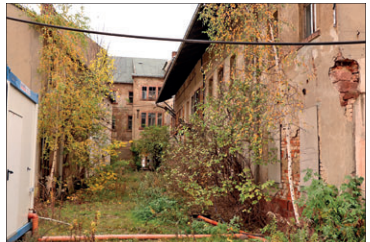
Nach Fertigstellung soll das Vorderhaus, Topfmarkt 9, ebenfalls noch saniert werden. (Im Foto: Rückansicht)
