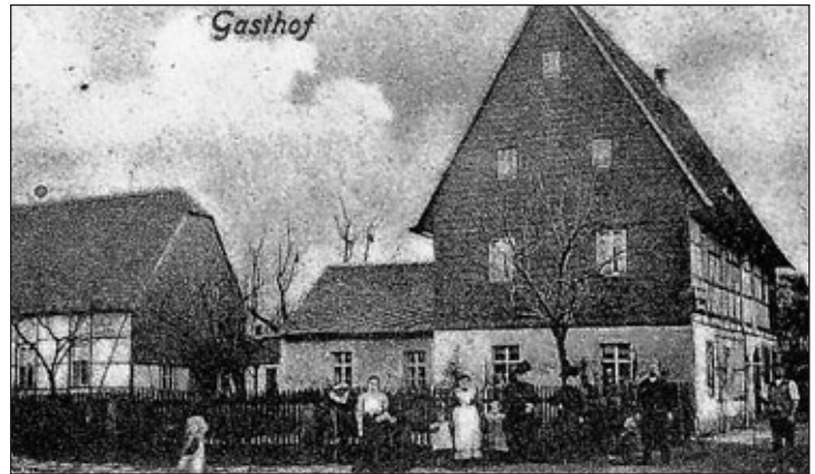
Alter Gasthof von Noßwitz mit Anbau und Tanzsaalgebäude links (zuletzt Kulturhaus), Noßwitz No. 44 Eigentümer: Nitzsche, Riedel, Traugott, Conrad, Krause, Hausmann, Sacher, Speer, erbaut als Wohnstallhaus um 1750 Bildquelle: Ansichtskarte um 1900
