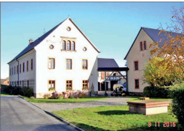
fach- und denkmalgerecht saniert ab 2000 von Arno Singer, vorher war es Büro und Betriebsküche der LPG Bergfrieden Typ 1, später LPG Bergland Bildquelle: W&R Richter, Noßwitz 2016
