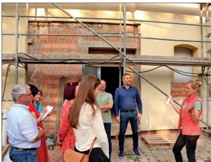
Bauingenieurin Simone Pfeifer (r.) erläutert den Stadträten vom Planungs- und Bauausschuss den Stand der Bauarbeiten.
