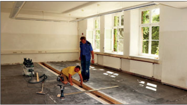
Erweiterung des Computerkabinetts in der Oberschule „An der Mulde“. Zur barrierefreien Unterbringung eines neuen Kabelkanals mussten massive Eingriffe im Fußboden vorgenommen werden.
