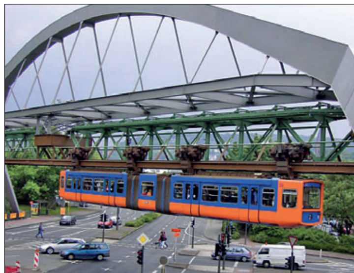
Wuppertal: Schwebebahn über der B7 Foto: Oktaeder, Gemeinfrei, https://commons.wikimedia.org/w/index.php?curid=34148
