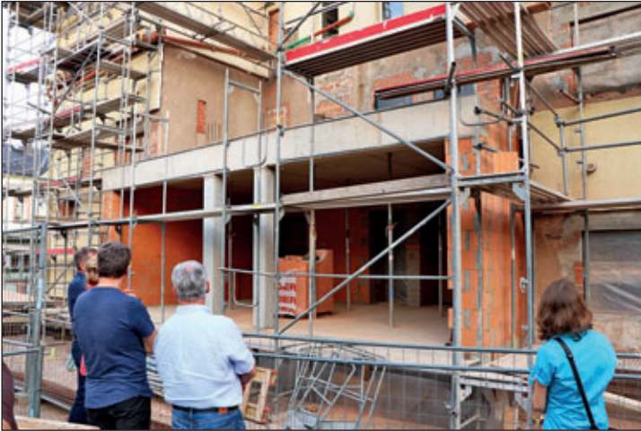
Anbau von Gruppenräumen an der Nordfassade
