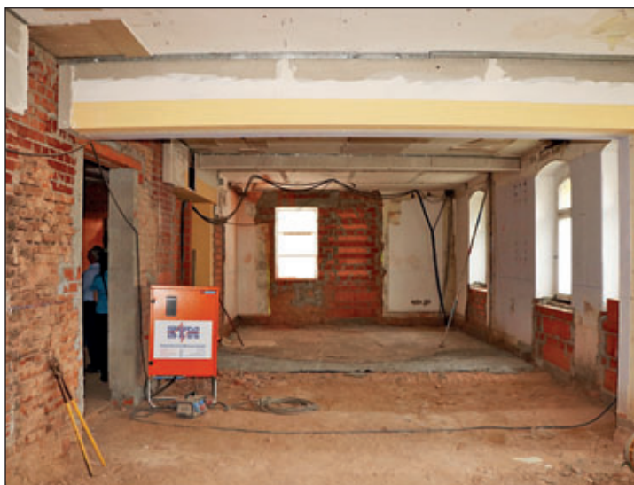
Künftiger Multifunktionsraum im Erdgeschoss
