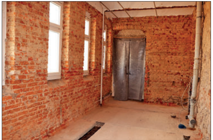
Oberschule „An der Mulde“: Baustelle Toilettenanlage Jungen – 92.000 Euro soll die Gesamtmaßnahme in Anspruch nehmen.
