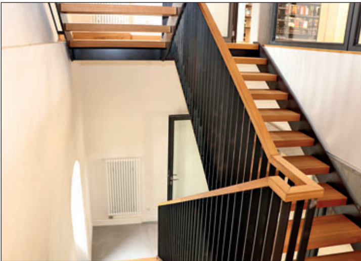
Eine stählerne Treppenkonstruktion, belegt mit Eichenbrettern, verbindet die drei Etagen. Nach Bedarf kann auch der neuinstallierte Personenaufzug benutzt werden.
