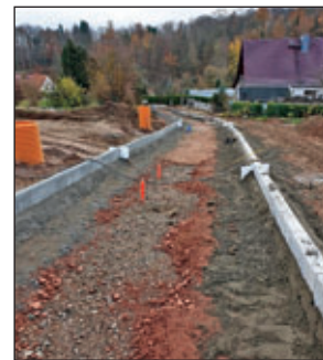
Erschließung Wohngebiet „Am Weinberg“
