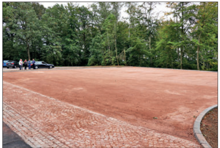
Neuer Parkplatz auf dem Rochlitzer Berg wurde freigegeben. Die 600 Quadratmeter große Fläche bietet zusätzliche Stellplätze für rund 40 PKW.
