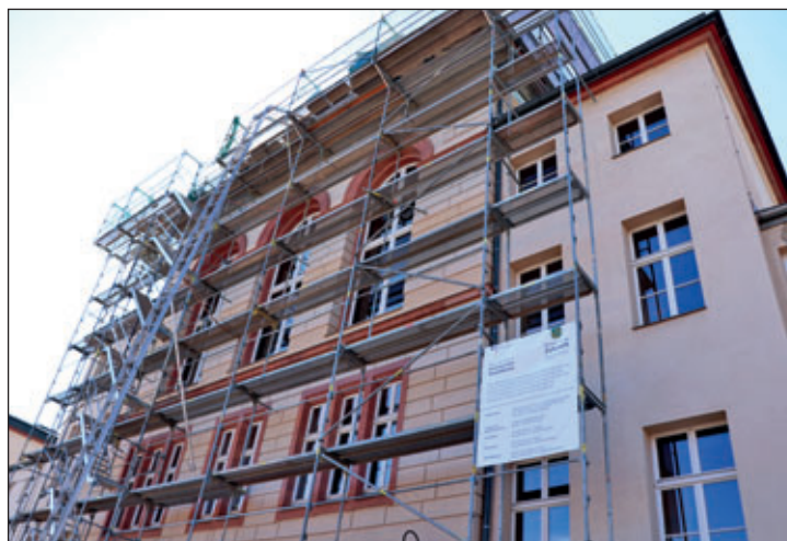
Dach über Aula und Speisesaal an der Oberschule erneuert
