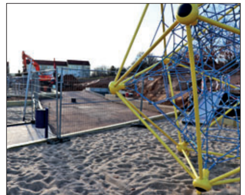
Die Bauarbeiten im Außengelände werden planmäßig fortgeführt.
