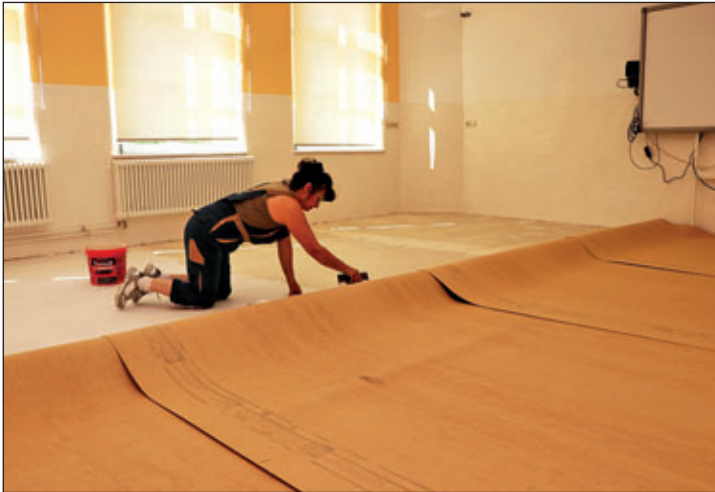
Handwerker nutzten schulfreie Zeit. In der Grund- und Oberschule wurden über die Sommerferien Renovierungsaufträge von über 30.000 Euro vergeben. Im Foto: Fußbodenbelagserneuerung in der Oberschule „An der Mulde“
