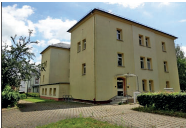
Zur Umnutzung des Gebäudes Poststraße 18/20 zu einer Kindertagesstätte (Hort) sind die Bauarbeiten in vollem Gange.
