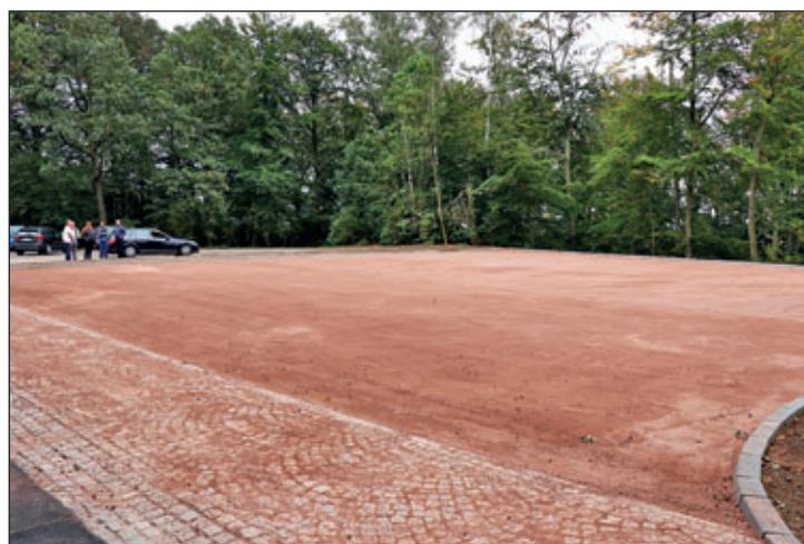
Freigabe des neu errichteten Parkplatzes am Waldschlösschen auf dem Rochlitzer Berg.
