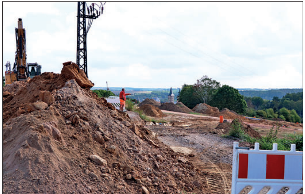
Tiefbauarbeiten und Kabelverlegung zur Erschließung des neuen Rochlitzer Wohngebietes „Am Weinberg“. Foto: Jörg Richter
