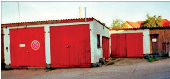
Zweites Feuerwehrgerätehaus der Noßwitzer Wehr
