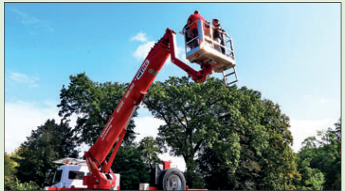
Mit der Arbeitsbühne der Fa. LIFTEC geht's hoch in die Lüfte.
