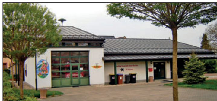
Das dritte Feuerwehrdepot der Noßwitzer Wehr, übernommen im Jahre 2001
