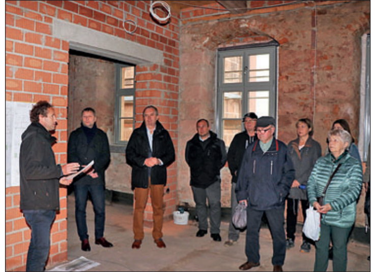
Bauleiter Steffen Liebers (li.), vom Architektenbüro Ueberschär und Knoll, erklärt an Hand von Grundrissen die geplanten Umbauarbeiten.
