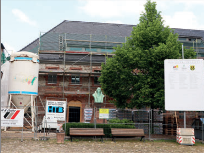
Stadtbibliothek Südseite nach erfolgter Dacheindeckung mit Biber-schwanzziegeln
