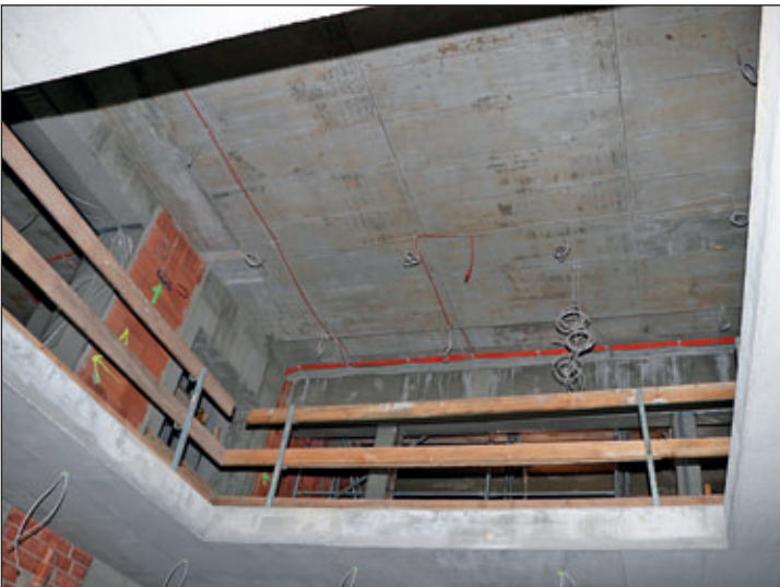
Eingangsbereich mit Blick zur offen gestalteten Decke
