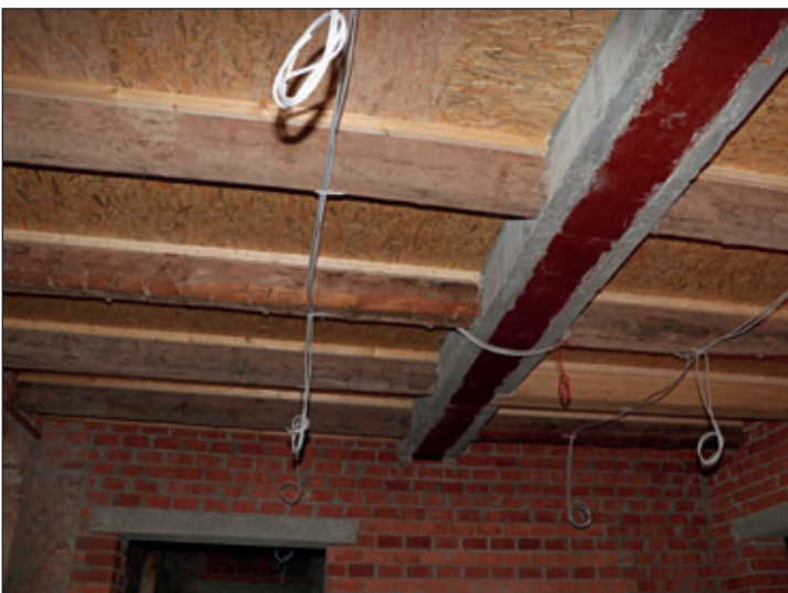
Mit einem eingezogenen Stahlträger im Erdgeschoss wurden die bisherigen Deckenspannweiten von sechs Metern halbiert. Diese Maßnahme war notwendig, um die Deckenlasten vom aufkommenden Medienbestand im 1. OG abzufangen.
