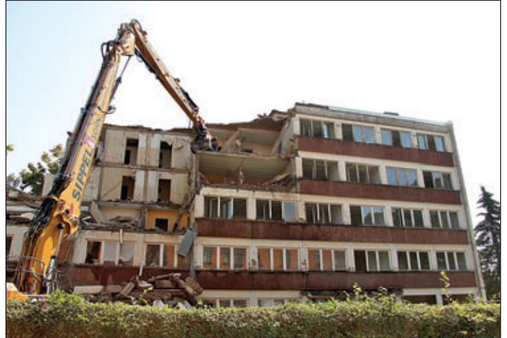
Rückbau Verwaltungsgebäude LISt in der Seminarstraße
