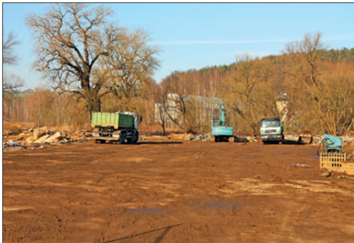
Rückbau der ehemaligen Kunststofftechnik an der Waldheimer Straße
