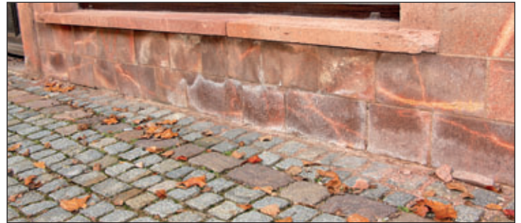
Folgeschäden von Nässe und Streusalz an einer Hausfassade
