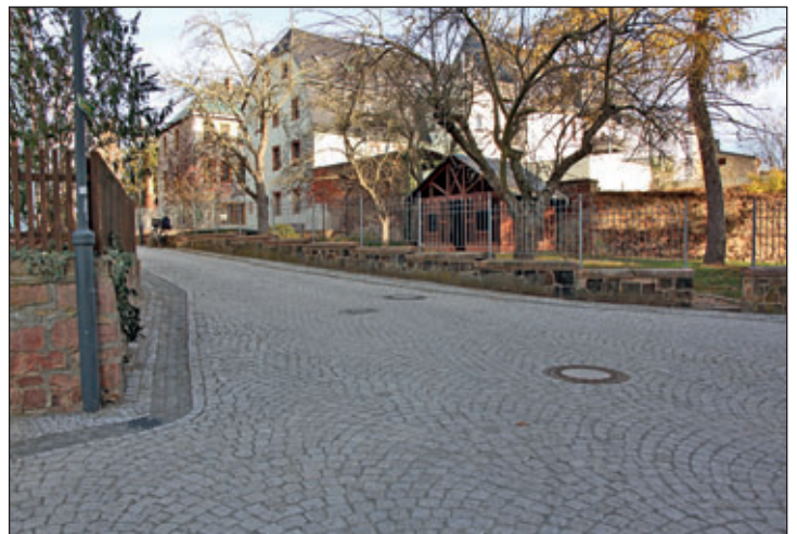
Hohe Gasse wurde auf der Gesamtlänge von 79 Metern saniert.
