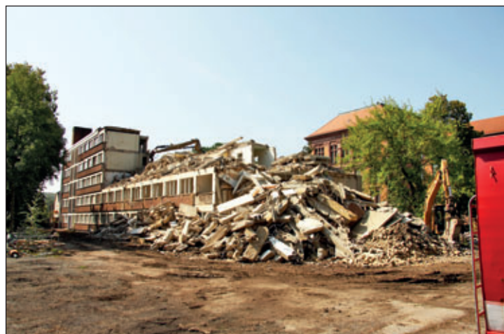
Rückbau des LIST-Verwaltungsgebäudes in der Seminarstraße Archivbilder: Jörg Richter
