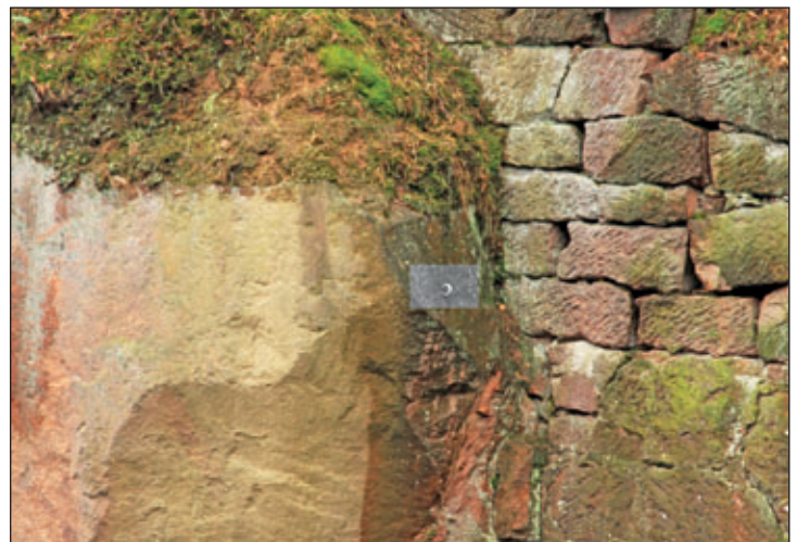
Neu montierter Sicherheitsring im Gletsbergbruch
