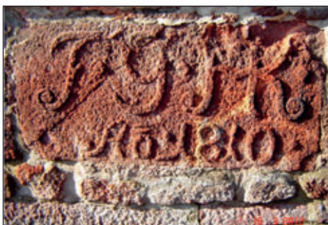
Abb. 22: Alter, von anderen Orten, eingebauter Denkstein an der Stützmauer des Gutes Obuch, Noßwitzer Hauptstraße Nr. 32
