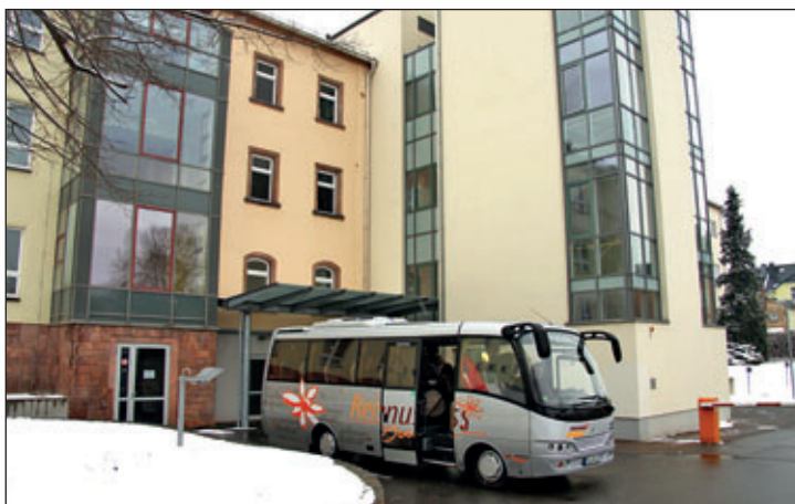
Ehemaliges Rochlitzer Krankenhaus: Die Landkreis Mittweida Krankenhaus gGmbH will weiterhin an dem Gebäude festhalten und nach dem Erhalt von Fördermitteln ein Gesundheits- und Pflegezentrum etablieren.
