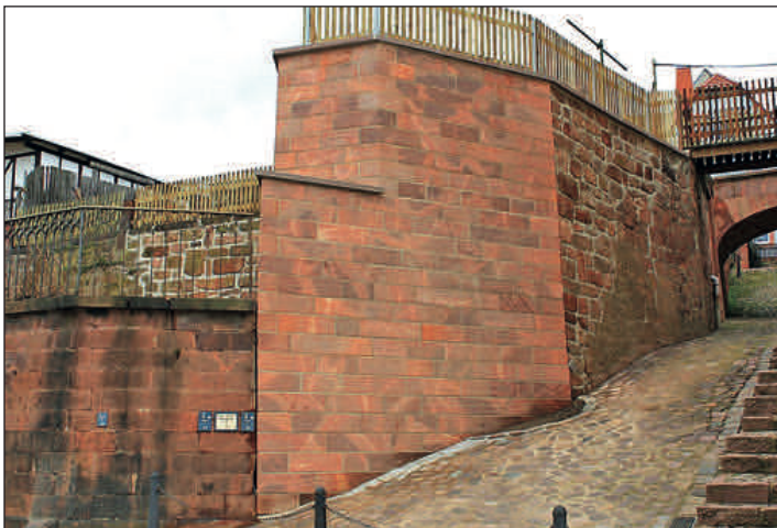
Sanierung und Ersatzneubau der Stützwand Hohe Gasse
