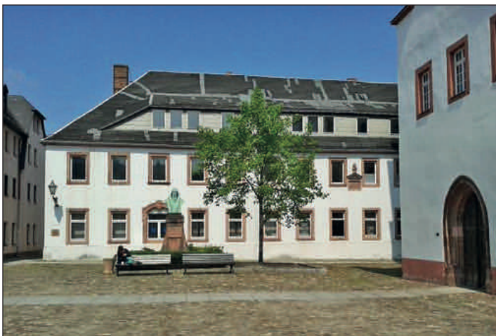
Zur Sanierung und Modernisierung der Stadtbibliothek sind die ersten Ausschreibungen angelaufen.
