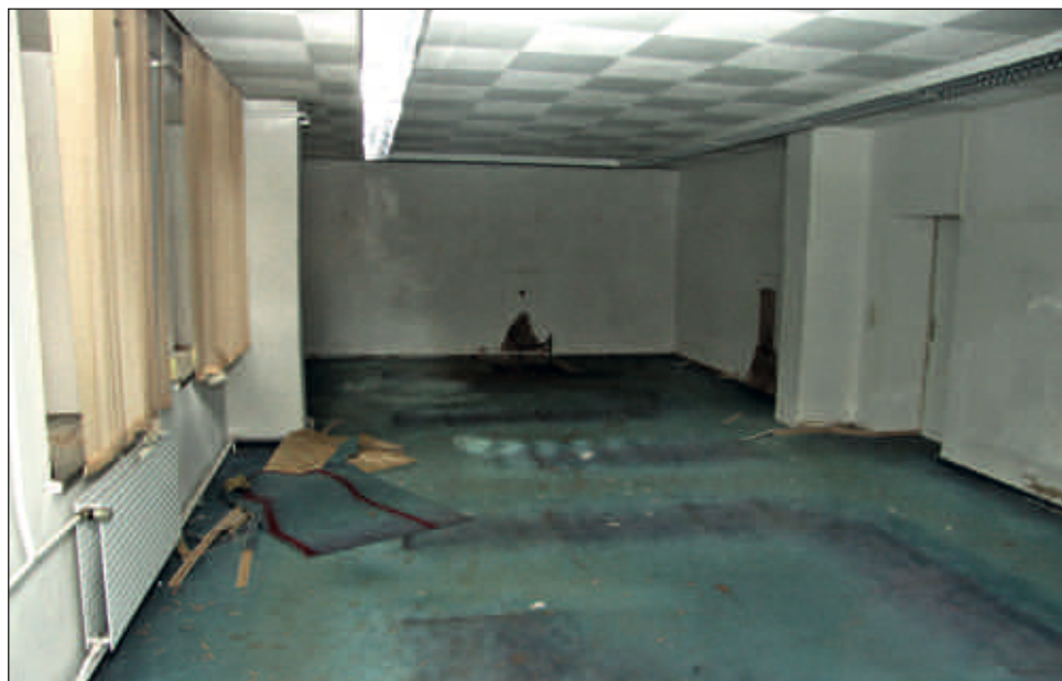
Einer der Innenräume des Bibliotheksgebäudes – hier werden demnächst Entkernungsarbeiten durchgeführt.
