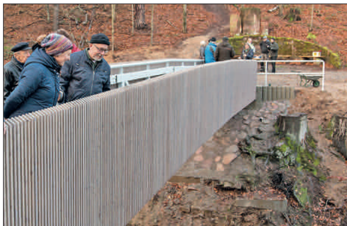
Zur besseren Harmonisierung mit dem Umland hat die Metall-Fachwerkbrücke eine Lärchenholzverkleidung erhalten.
