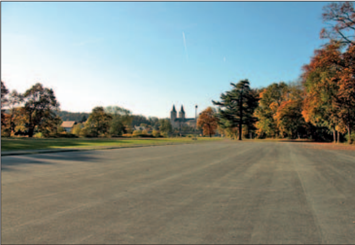
Die Deckensanierung des ehemaligen Fahrschulplatzes auf der Muldeinsel ist abgeschlossen. Die Bauabnahme erfolgte am 09.10.2017.
