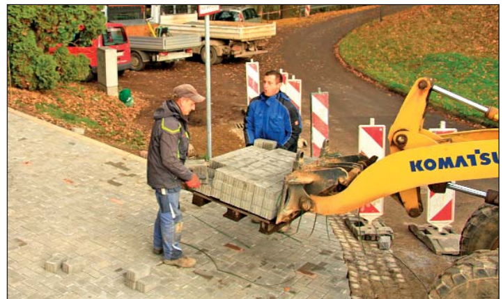
Mitarbeiter der Fa. Steffen Nagel STN-Tiefbau bei abschließenden Pflasterarbeiten im Eingangsbereich
