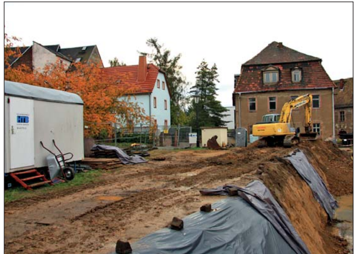
Stützmauer Hohe Gasse wird saniert - die Kosten der Baumaßnahme belaufen sich auf rund 182.000 Euro.
