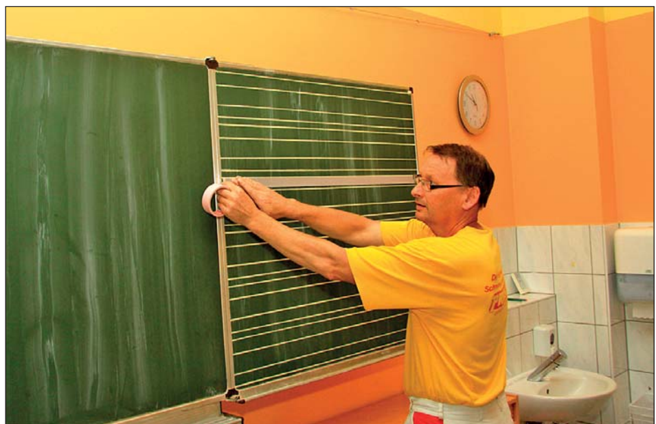
Linienabstand nach Maß - nur noch Klebeband abziehen und fertig. Malermeister Reiner Knoll (Rochlitz) bei der Aufarbeitung einer Schultafel.
