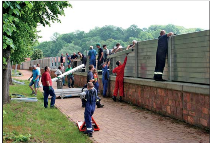
Aufbau der mobilen Hochwasserschutzwand an der Uferstraße
