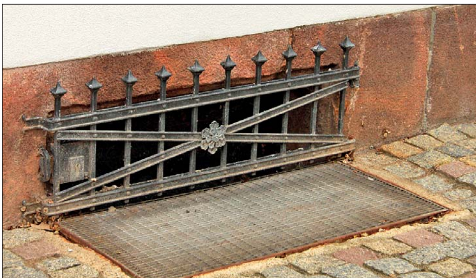
164 Diebstähle gelangten 2015 zur Anzeige, die Hälfte davon ohne erschwerende Umstände. im Foto: Robuste Fenstergitter sorgen gerade im Kellerbereich von Gebäuden für mehr Einbruchsicherheit.
