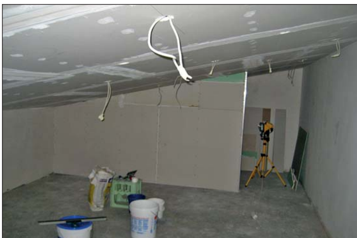
der Trockenbau ist fertig
