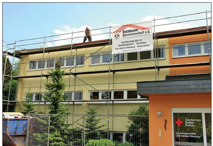
Die Dacheindeckung an der Kindertagesstätte „Die Kleinen Strolche“ ist ebenfalls in vollem Gange.
