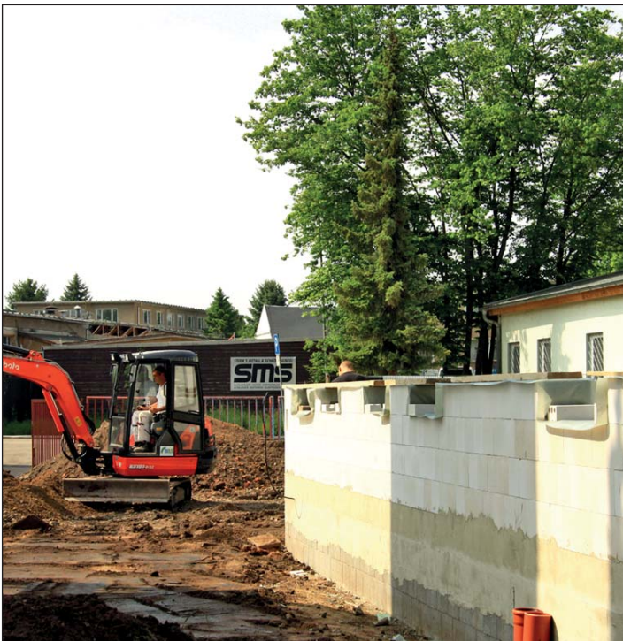
Seit Anfang Mai laufen die Bauarbeiten zur Errichtung des neuen Domizils für den VfA Rochlitzer Berg e.V. Der Anbau erfolgt an das BSC-Vereinsheim am Vater-Jahn-Sportplatz.
