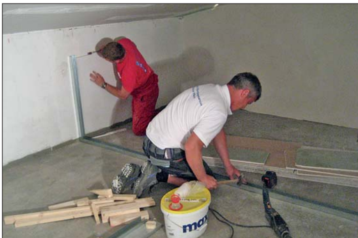
Setzen des Ständerwerkes
