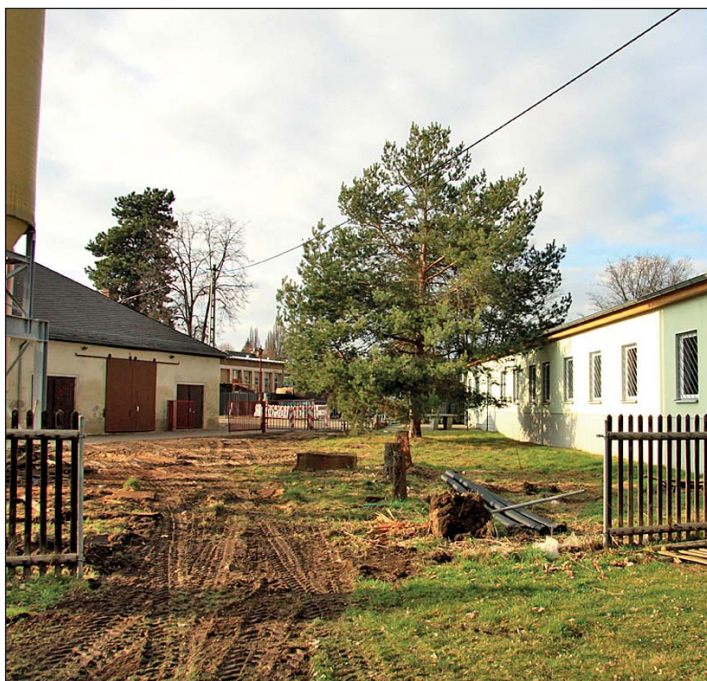
Für den geplanten Anbau der VfA-Vereinsräume an das BSC-Gebäude Schützenstraße läuft seit vergangener Woche das Ausschreibungsverfahren. Im Foto: künftiges Baufeld
