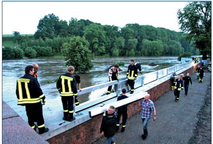
Kameraden der Freiwilligen Feuerwehr Rochlitz, Anwohner und freiwillige Helfer beim Aufbau der mobilen Schutzwände an der Uferstraße, Foto: Jörg Richter
