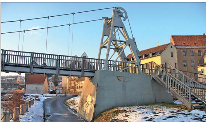
Hängebrücke Rochlitz - Zaßnitz, hier soll 2016 die Instandsetzung der Betonunterbauten erfolgen.
